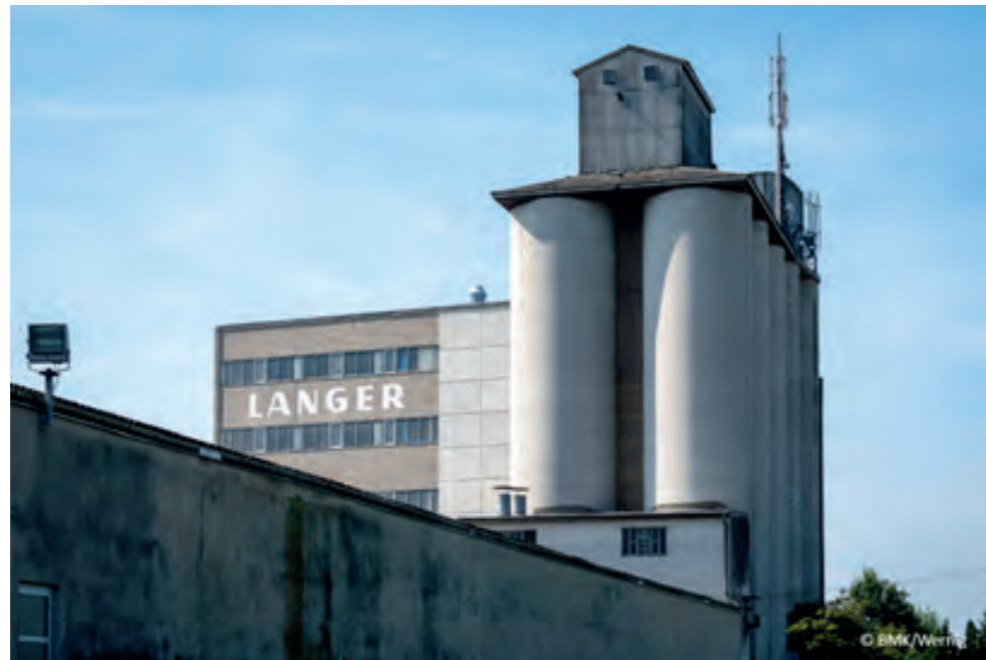
Ehemalige Getreidemühle Langer in Obergrafendorf (NÖ)
